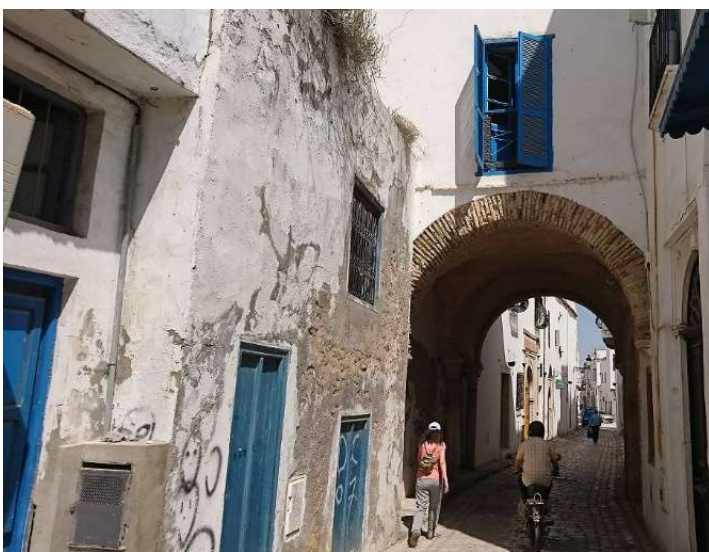
路地にアーチ状のトンネルを造り、その上に部屋を建築する
