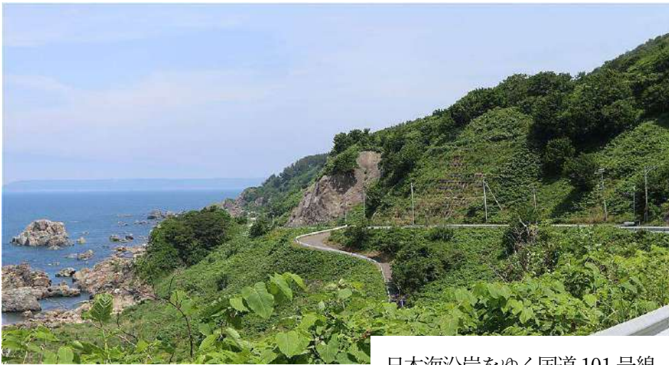
日本海沿岸をゆく国道101号線
