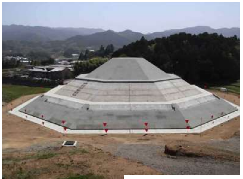
造成工事中の牽牛子塚古墳
